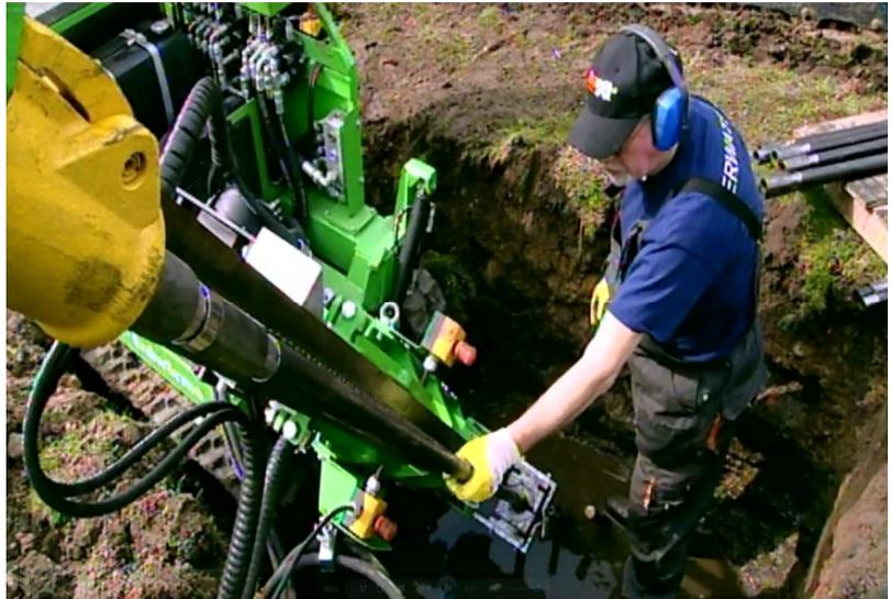
Abb.: selbst entwickelte Hydraulik-Rammbohrlafette
