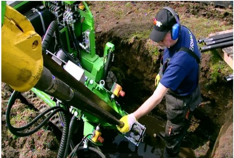
Abb.: selbst entwickelte Hydraulik-Rammbohrlafette
