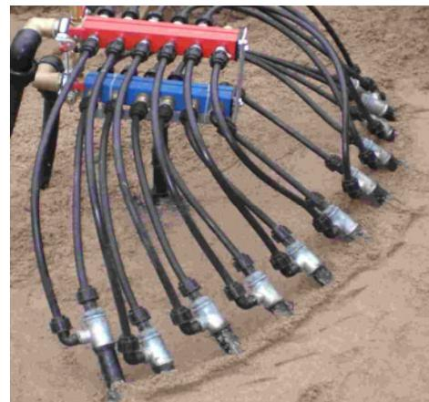
Abb.: abgeteufte Sonden mit Anbindung an den Verteiler
