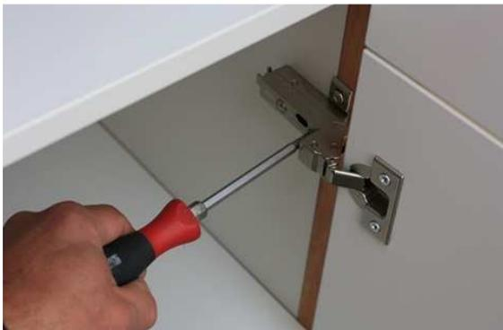
Lösen Sie die Schrauben mithilfe eines Akku-Schrauber- oder Schraubenziehers leicht und schieben Sie die Front hoch oder runter.
