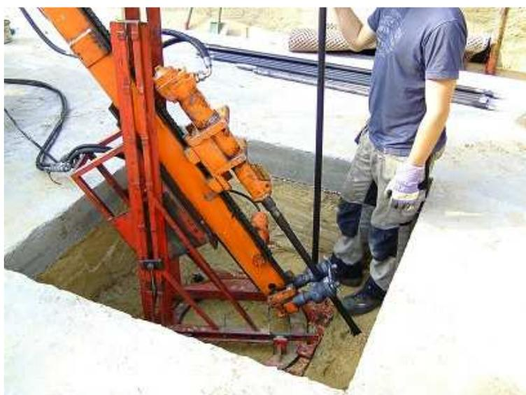
Abb.: Einbringung der Sonden in bzw. unterhalb der Gebäudesohle
