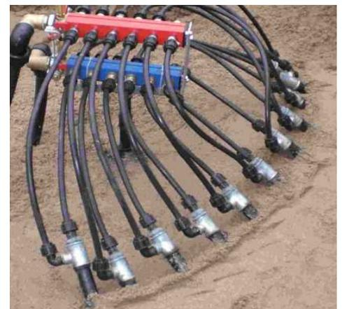
Abb.: abgeteufte Sonden mit Anbindung an den Verteiler
