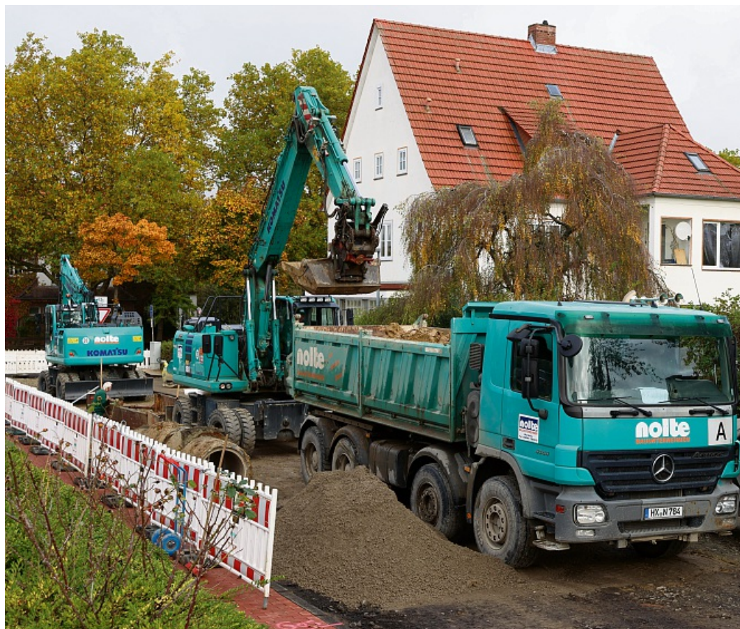
Erste Rohre verlegt: An der Einmündung zur Bahnhofstraße ging es los. FOTOS: TANJA TEMME
