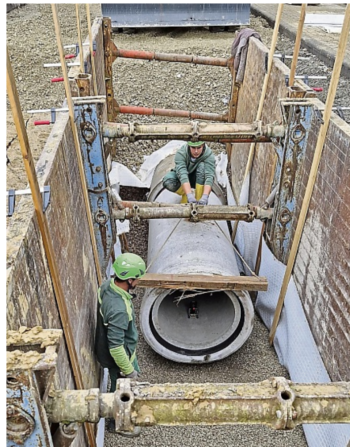
Neue Rohre: Nur bei Starkregen wird nicht gearbeitet.
