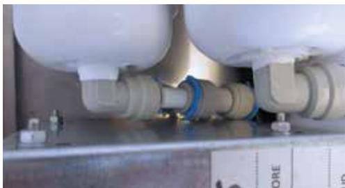
**Beachten Sie die richtige Reihenfolge:** Das Wasser durchläuft zuerst den Sedimentfilter, danach den Carbon-Filter.
